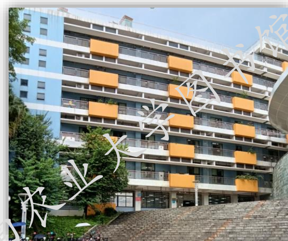
东区分馆所在楼 分馆位置：教四一楼和三楼
